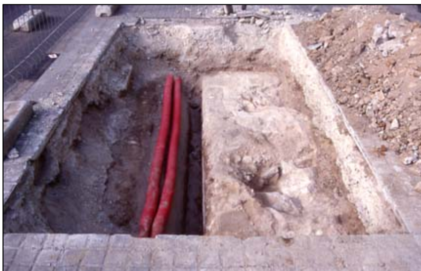
Vista general del sondeig 2000
